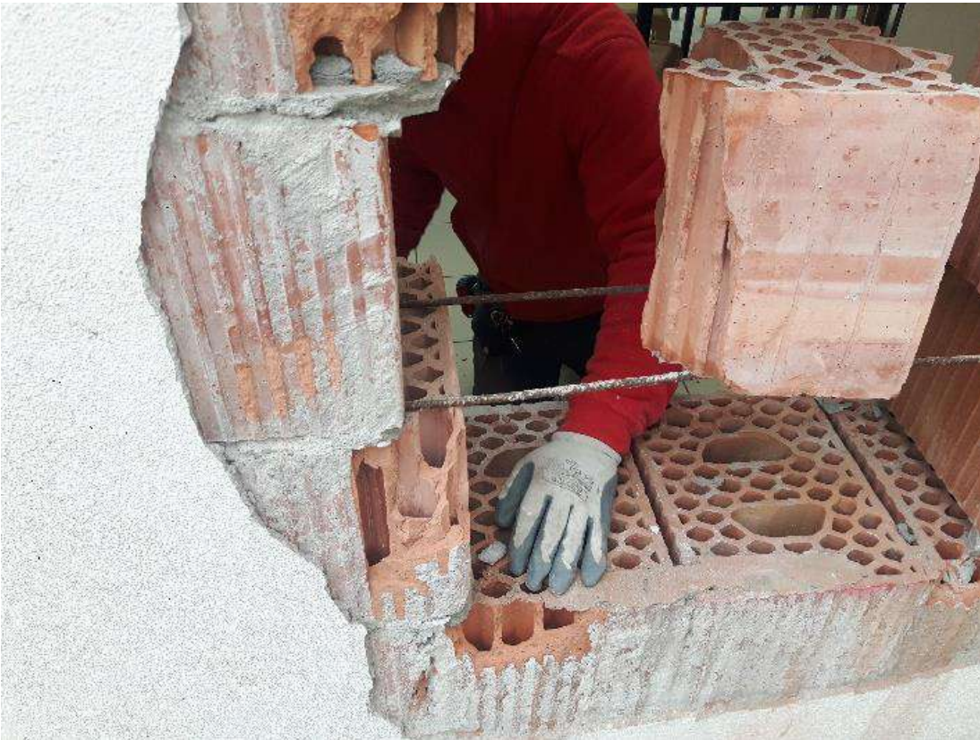
presenza armatura e mancanza di malta
